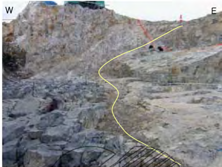
그림 14. 1호기 보조건물 SUMP 지역의 N-S 계열의 연약대
