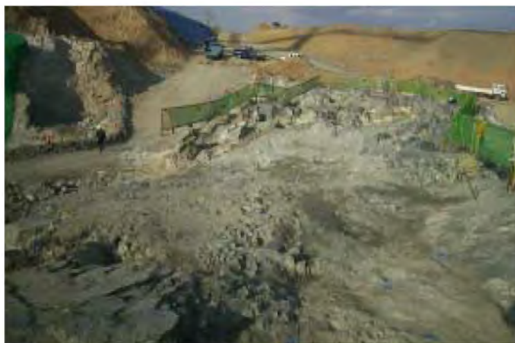
그림 4.2.2.5-18 2호기 터빈건물 TGB2-13 및 14 지역 저경사 연약대(S→N)
