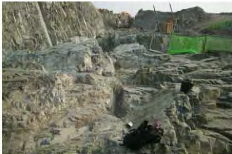
그림 4.2.2.2-15 2호기 보조건물 AB2-05지역 동북동-서남서 방향의 연약대 및 절리조밀 지역에 대한 굴착지역(SW→NE)
