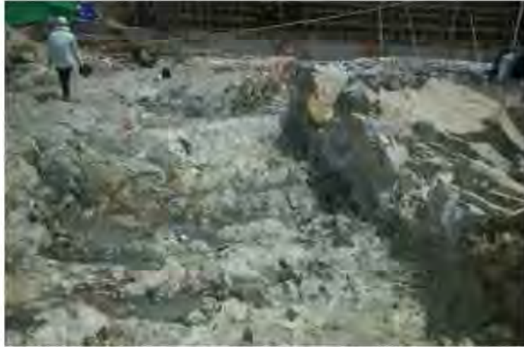
그림 4.2.3.1-39 복합건물 CPB-10 지역에 발달하는 저경사 연약대 및 절리조밀지역에 대한 보강굴착지역 (N→S)
