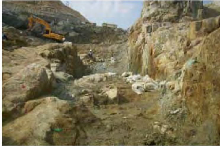
그림 4.2.3.2-19 남-북 방향 연약대 주변지역의 보통풍화 및 심한풍화 혼재 지역(S→E)
