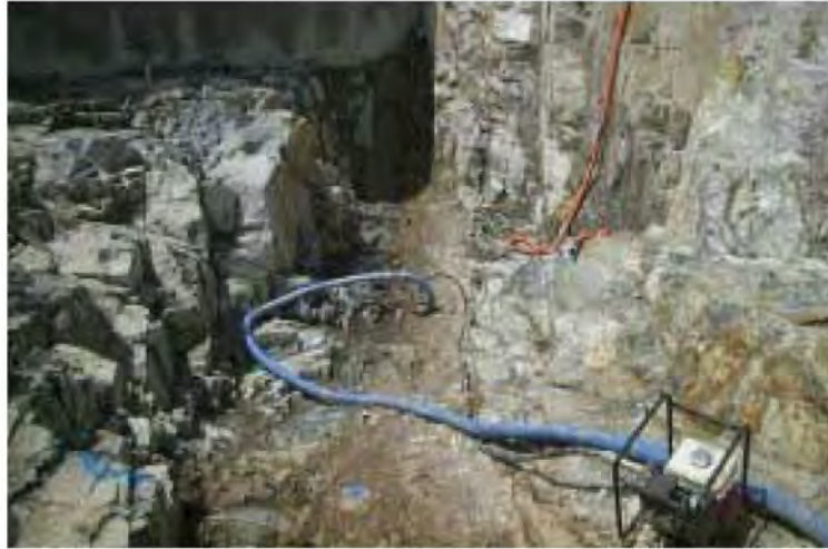
그림 4.2.3.1-31 복합건물 CPB-05 지역에 발달하는 A-A' 연약대에 대한 보강굴착지역(NE→SW)
