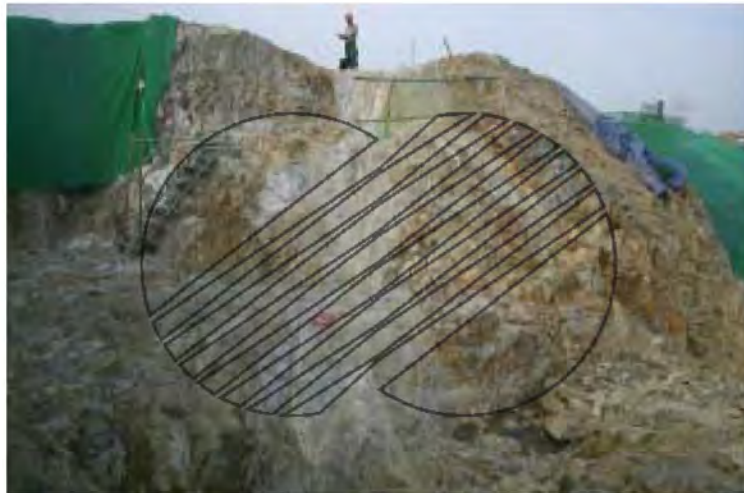
그림 4.2.2.4-5 2호기 핵연료건물 FHB2-01 및 06 지역의 연약대(SW→NE)
