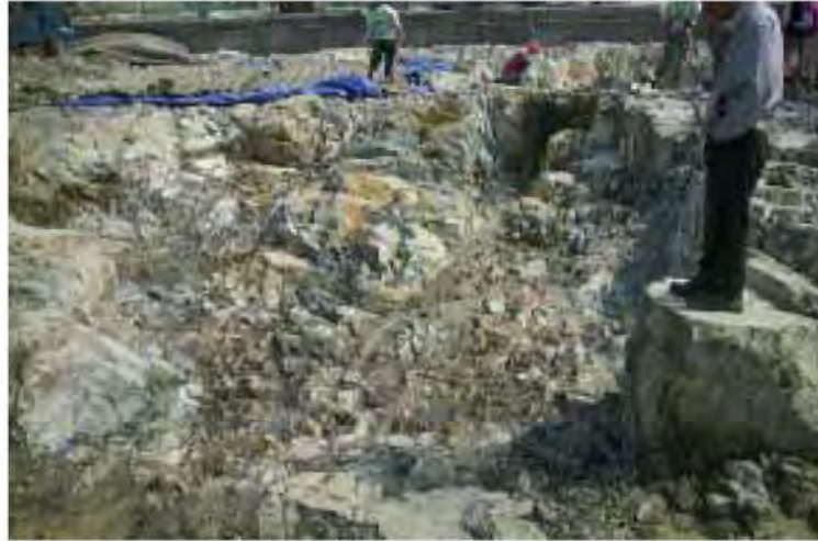
그림 4.2.3.1-36 복합건물 CPB-08 지역에 발달하는 절리조밀지역 보강굴착 지역(N→S)
