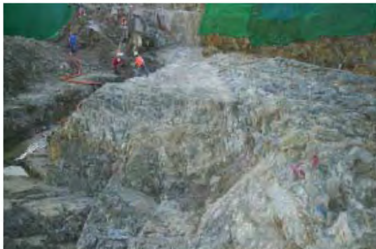
그림 4.2.2.3-7 2호기 비상디젤발전기 건물 EDGB2-01 지역의 연약대(E→W)
