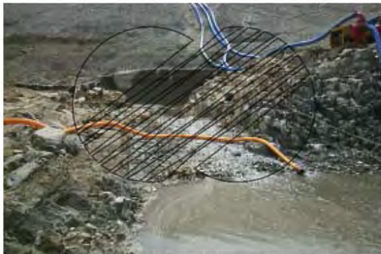
그림 4.2.3.2-22 남-북 방향 연약대 발달지역에 국지적으로 발달하는 보통풍화 및 심한풍화 혼재 지역(N→S)
