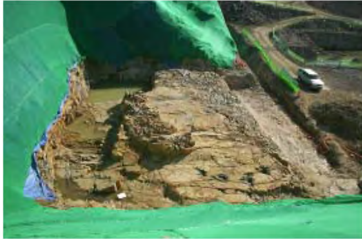
그림 4.2.2.3-2 2호기 비상디젤발전기건물 EDGB2-01 지역의 굴착면(W→E)
