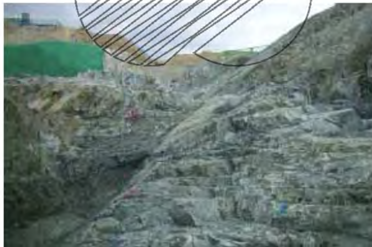
그림 15. 2호기 보조건물과 터빈건물 지역에 발달한 남-북 방향의 저경사 연약대(S→N)
