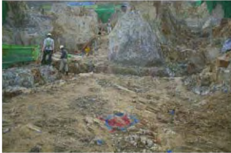
그림 4.2.2.4-7 2호기 핵연료건물 FHB2-02 동측지역의 연약대(ENE→WSW)
