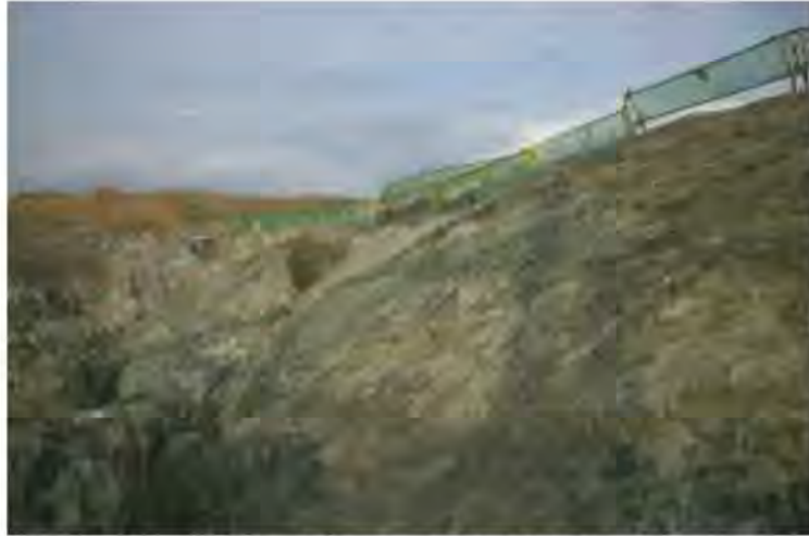
그림 4.2.2.5-23 2호기 터빈건물 TGB2-13 임시굴착사면 지역에 발달하는 연약대상의 암편 제거지역(S→N)
