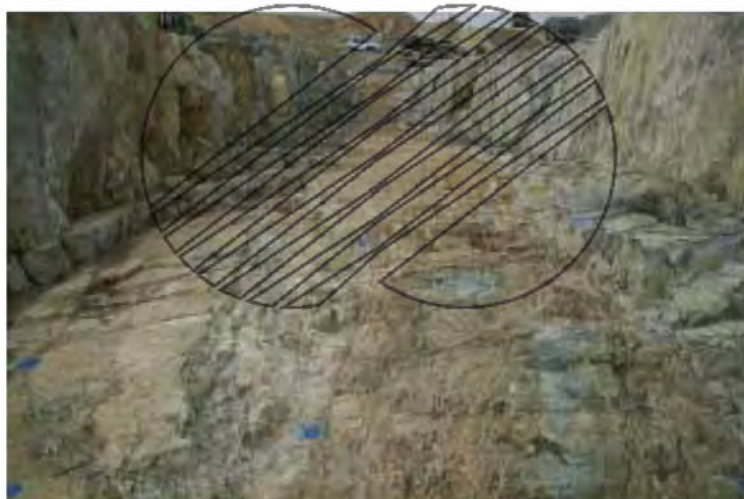
그림 4.2.3.1-32 복합건물 CPB-06~08 지역에 발달하는 A-A' 연약대에 대한 보강굴착지역(SW→NE)
