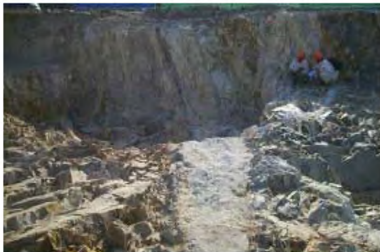
그림 4.2.2.4-9 2호기 핵연료건물 FHB2-05 및 06 지역의 관입암맥(NE→SW)
