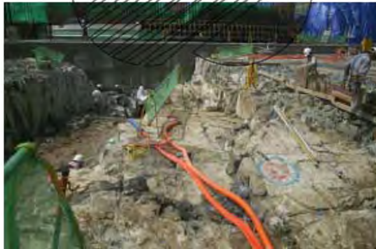
그림 4.2.3.1-37 복합건물 CPB-06 지역에 발달하는 절리조밀지역 굴착후(N→S)
