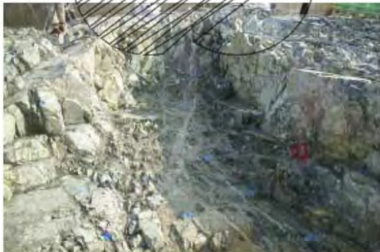
그림 4.2.3.1-35 복합건물 CPB-08 지역 B-B' 지역에 발달하는 연약대에 대한 보강굴착지역(N→S)
