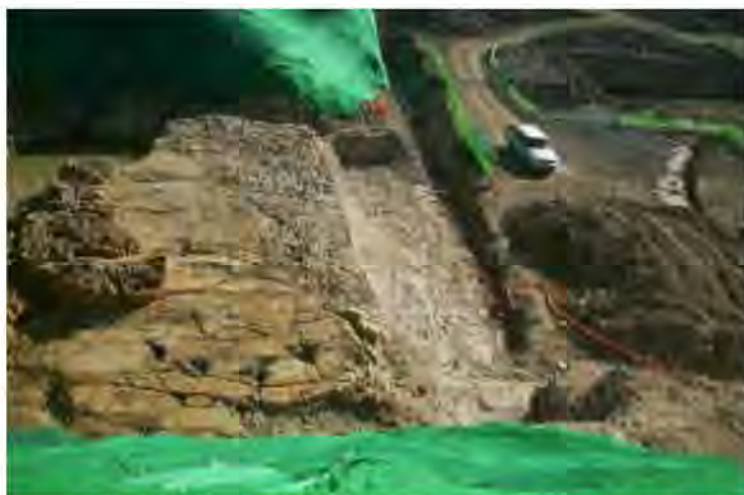
그림 9. 2호기 비상 디젤발전기 건물 지역 동북동-서남서 방향의 연약대(W→E)
