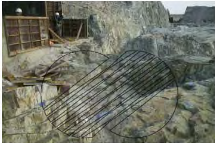
그림 4.2.2.2-14 2호기 보조건물 AB2-02 지역 동북동-서남서 방향의 연약대 및 절리조밀 지역에 대한 굴착지역(SW→NE)
