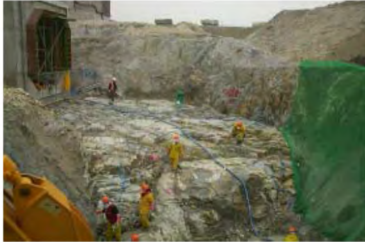
그림 4.2.3.2-2 1호기 냉각수 배수관로 CWDC- 8~9 지역의 굴착면(W→E)
