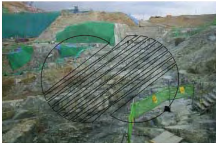
그림 4.2.2.2-12 2호기 보조건물 AB2-08 및 09 지역에 분포하는 연약대(S→N)
