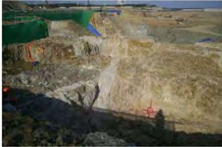
그림 10. 2호기 핵연료건물 지역 동북동-서남서 방향의 연약대(SW→NE)
