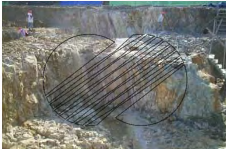
그림 4.2.2.4-8 2호기 핵연료건물 FHB2-05 및 06 지역의 관입암맥(NE→SW)
