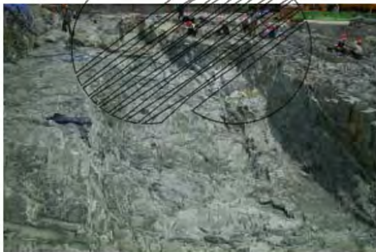
그림 4.2.3.1-38 복합건물 CPB-10 및 CPB-11 지역에 발달하는 저경사 연약대 및 절리조밀지역에 대한 보강굴착지역(N→S)
